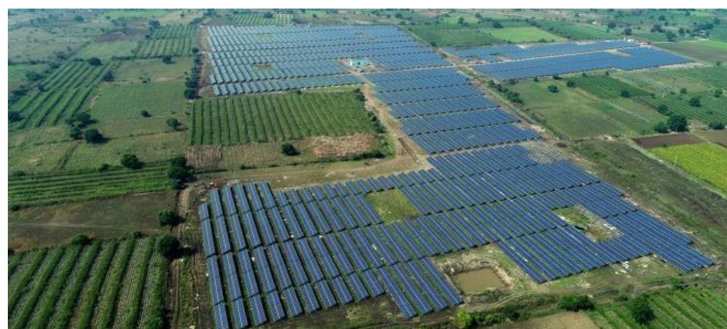
Figure 57 : Parc au sol, de TECHNIQUE SOLAIRE, en Inde à Maharashtra.
